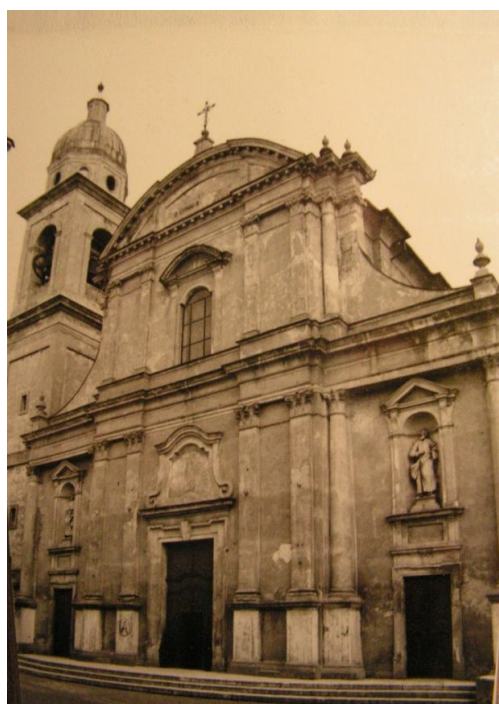
Situazione degli esterni al 1978. Notasi l'ammaloramento degli intonaci in facciata e la cospicua umidità di risalita nel muro della navata laterale. Foto di M. Fiaccadori
