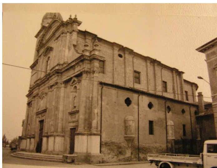
Situazione degli esterni al 1978. Notasi l'ammaloramento degli intonaci in facciata e la cospicua umidità di risalita nel muro della navata laterale. Foto di M. Fiaccadori
